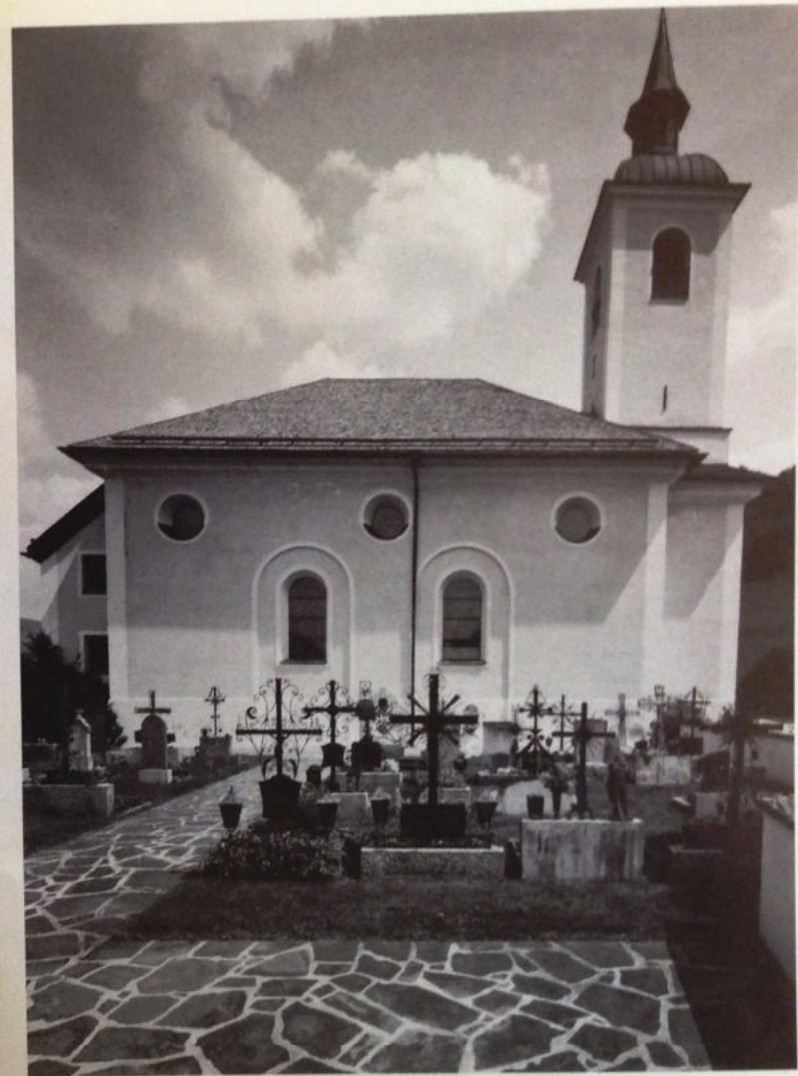
Die Kirche von der Südseite: links Sakristeianbau, in der Mitte das Kirchenschiff mit Rundbogen- und Kreisfenstern, rechts Risalit mit Turm
