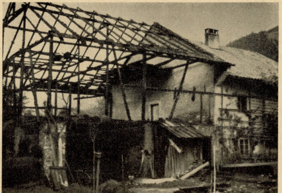
Ansicht des Stadelbrandes in Haiming. Die Feuermauer zwischen Haus und Stadel ist gut sichtbar.
